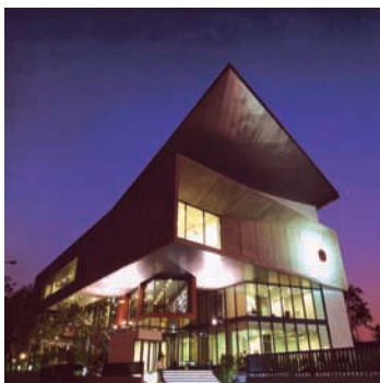
รูปที่ 8 อาคารสภาสถาปนิก
